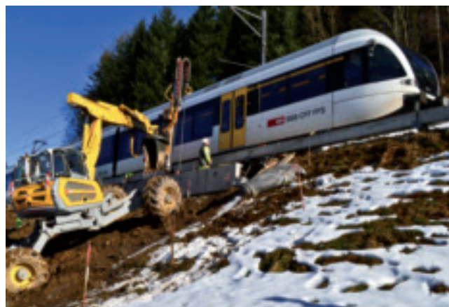
Bauarbeiten am Bahndamm.
