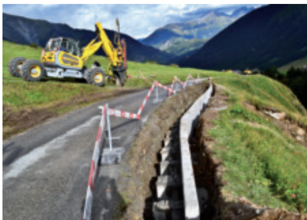
Stützmauererrichtung zur Strassensicherung in Sedrun.
