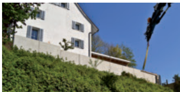
Gartenstützmauer in Wetzikon.
