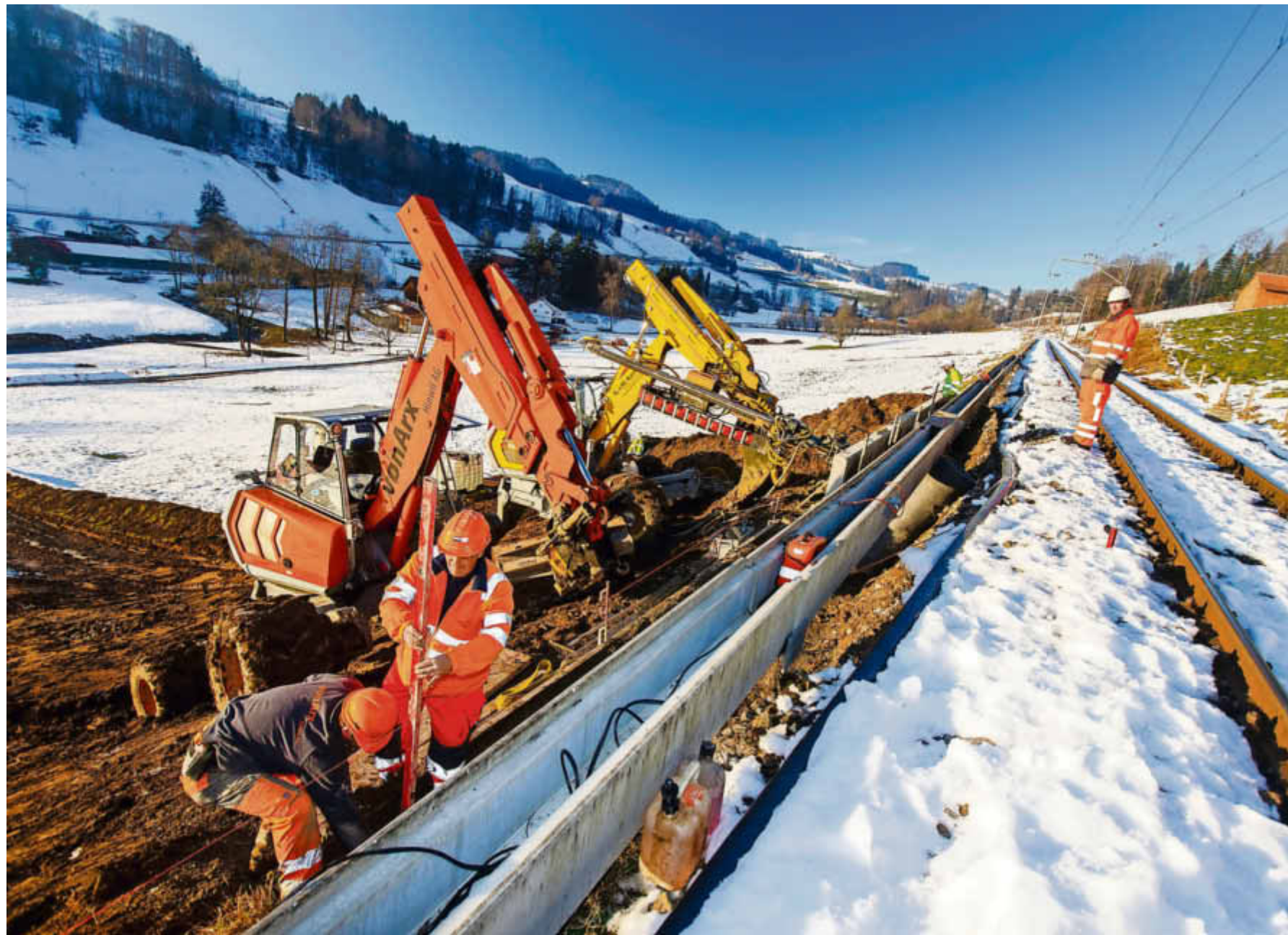
Wegen Bauarbeiten am Bahndamm muss die S-Bahn einen Streckenabschnitt beim Jonatal in Wald stark abgebremst passieren. Bild: Nicolas Zorvi
